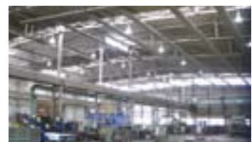
寝屋川車両工場のLED照明
