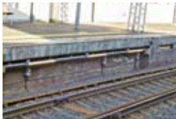
LED足下灯設備
