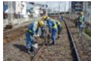
道床つき固め作業
