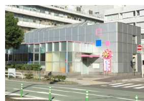
愛媛支店ビル敷地内の「ゆめみいよ保育園」
