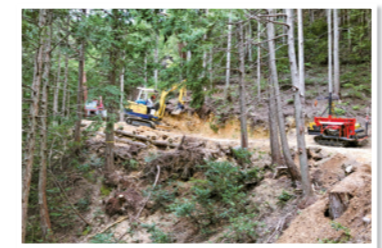
山門水源の森を次世代に引き継ぐ会：森林整備を効率的に行うための作業道作り。
