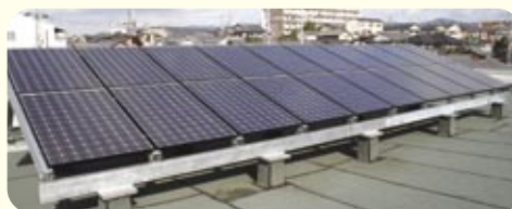
宇治支店の「太陽光発電パネル」
