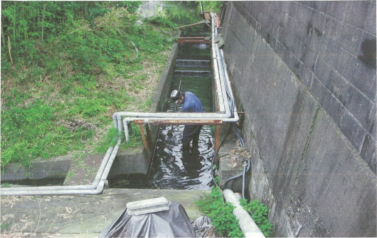
千軒の排水の 工場排水経路の清掃 千軒の排水
