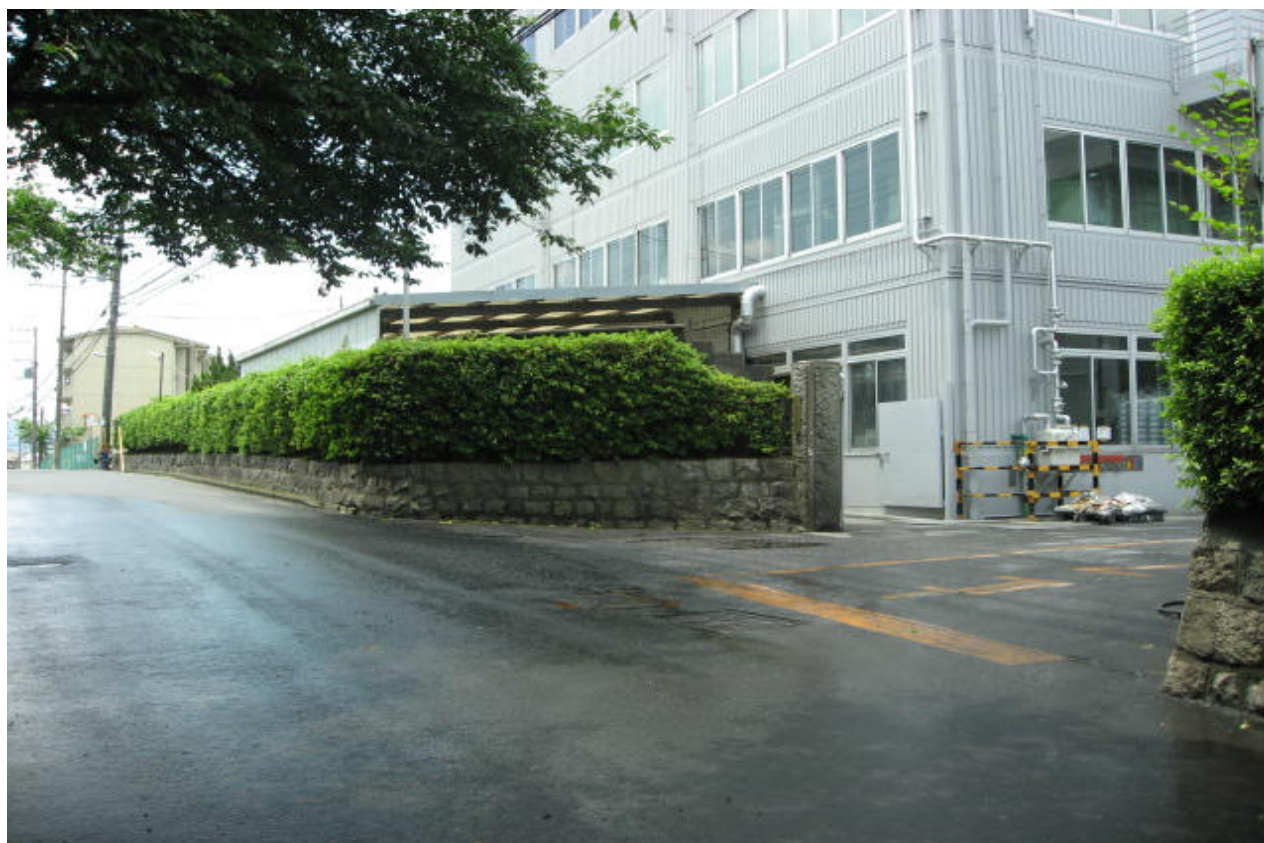
清掃された工場正門前
