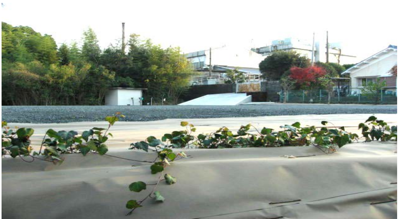
緑地化し、整備した工場の北境界
