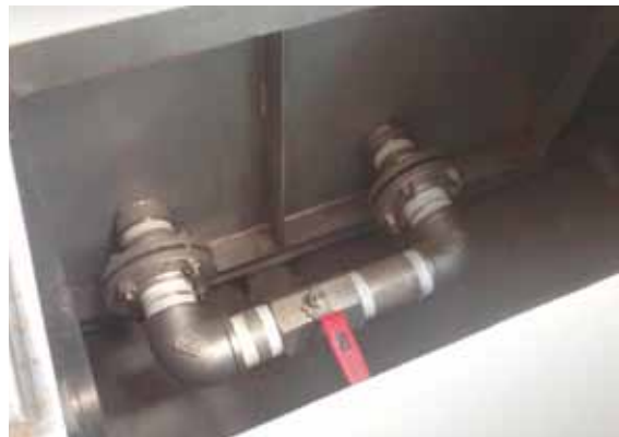
タンク二重底部分
