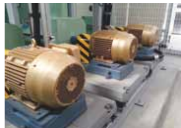
熱源設備の温水と冷水ポンプに高効率モーター
