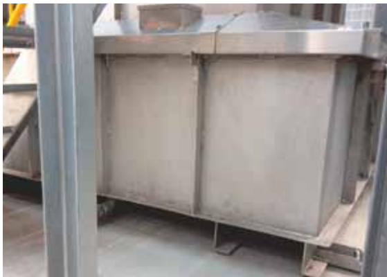
架空状態で設置
