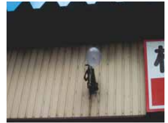
水銀灯からLED照明へ切替
