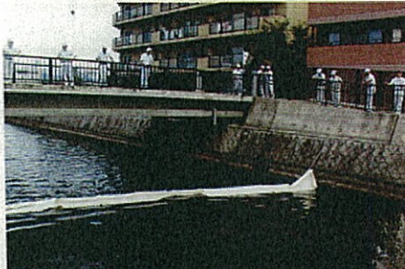
河口にオイルフェンス架設 河口にオイルフェンス設置による 油流出防止
