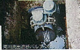
工場排出口へ 電動遮断弁設置
