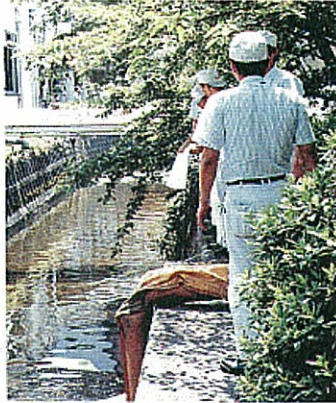
オイルフェンスで堰止め
