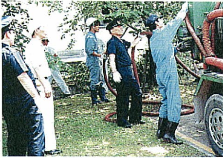
バキューム車による回収
