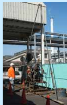
地下水調査風景
