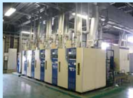
貫流ボイラ外観
