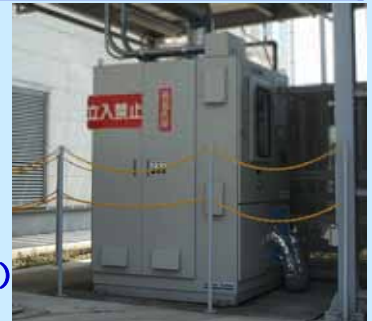
酸化エチレンガス燃焼装置
