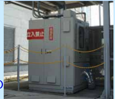
酸化エチレンガス燃焼装置
