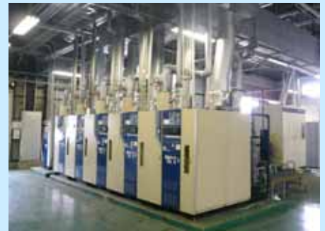
貫流ボイラ外観
