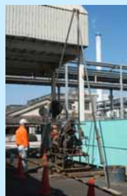
地下水調査風景
