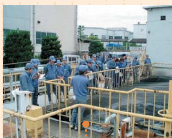
排水の処理設備
