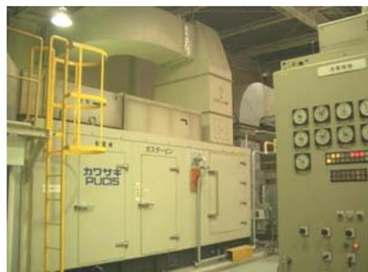
重油から天然ガスに燃料転換しSO<sub>x</sub>排出量を“0”にしたコージェネレーション設備
