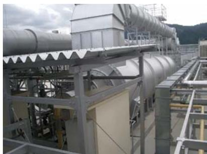
灯油から天然ガスに燃料転換しCO<sub>2</sub>排出量削減へ寄与した有機溶剤脱臭炉
